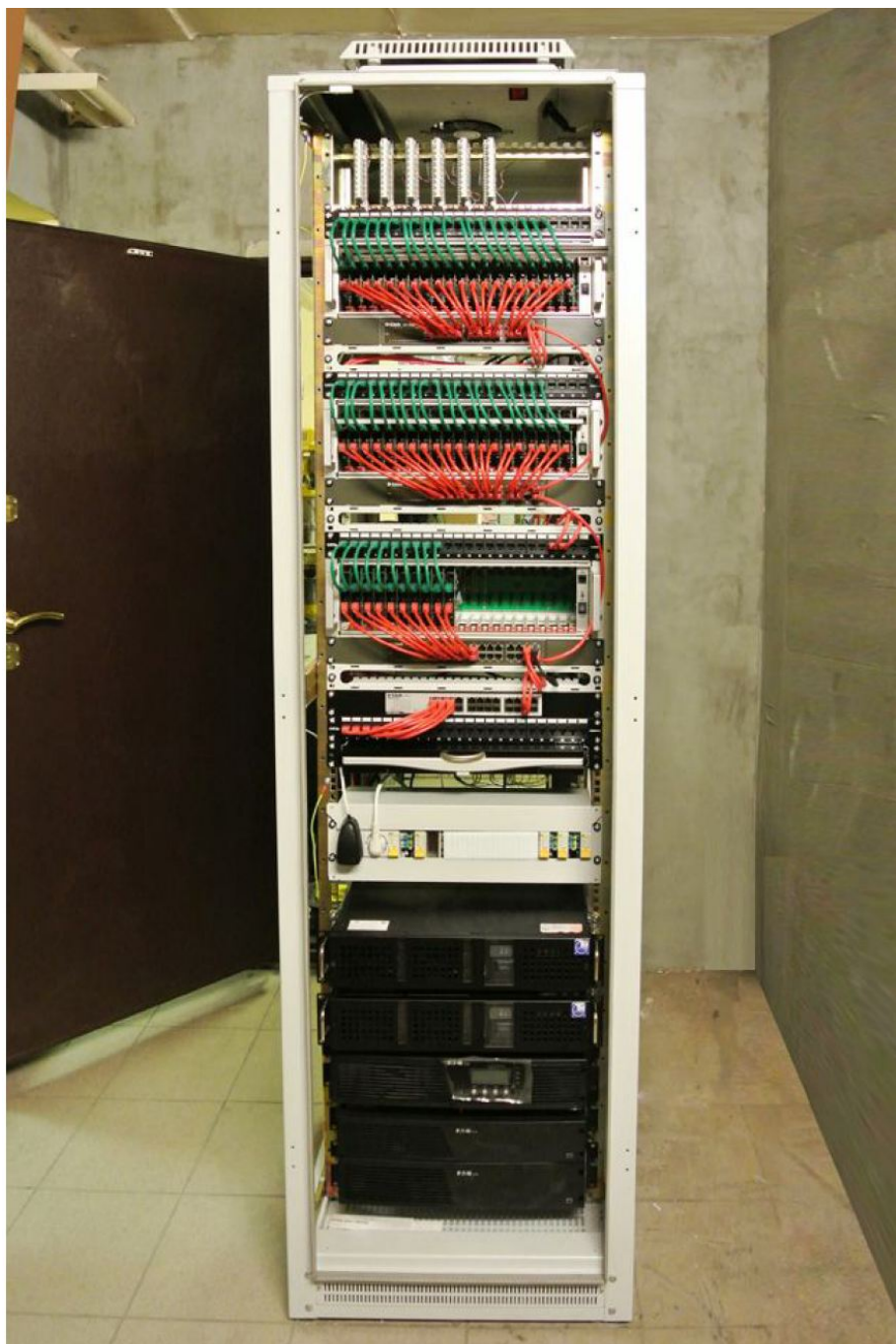
Шкаф ЦППС «ОИК Диспетчер НТ»
